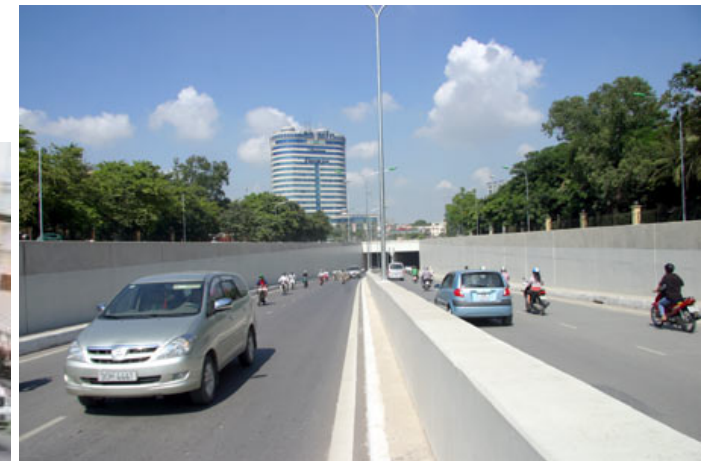
Photo of Kim Lien Tunnel
